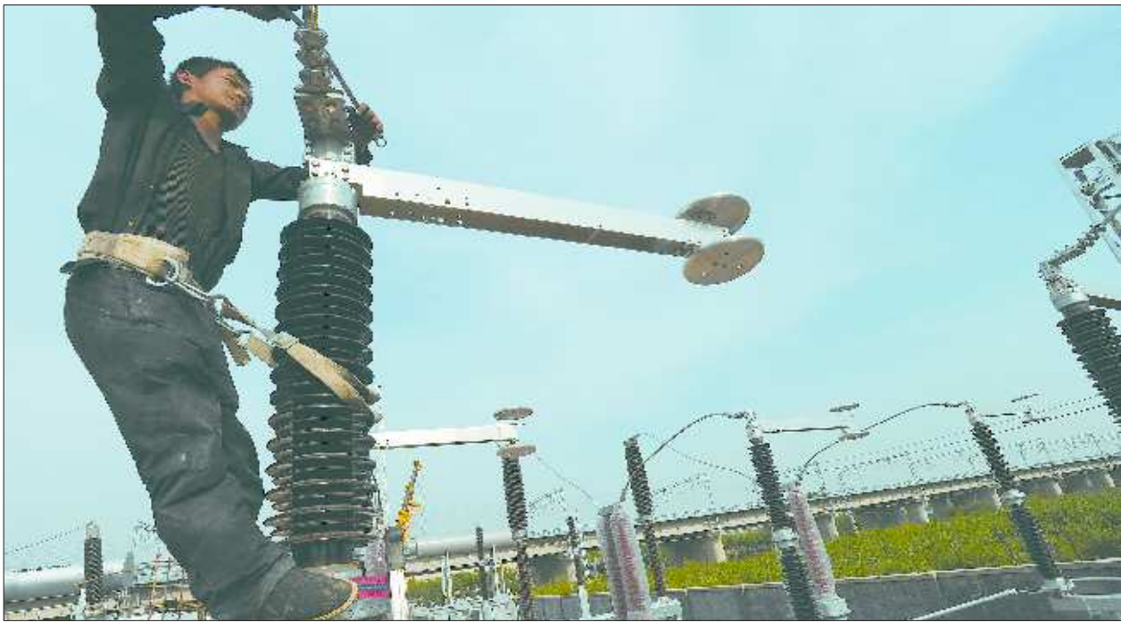
一名工人正安装高铁牵引站设备。
