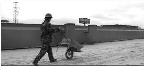
紧建设中的建材仓储园。
