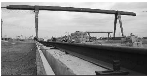
部分钢材的行吊已建设完毕。
