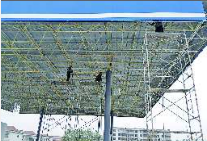
图为在东关南路加气子站,工人师傅们正在对顶棚龙骨进行焊接。 本报记者 贺超 摄
