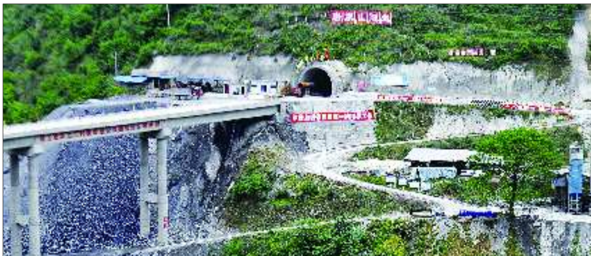
▲唐家山隧道在紧张的施工。
