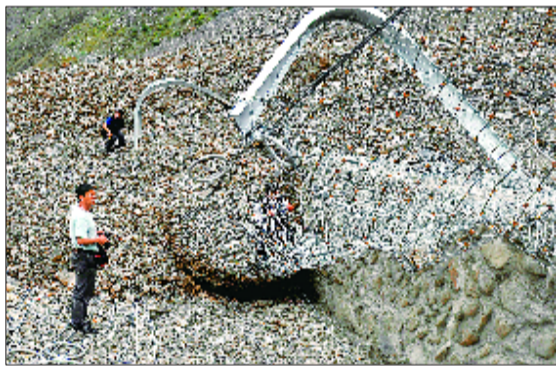
▲环湖路旁刚刚安装的护栏被泥石流冲垮。
