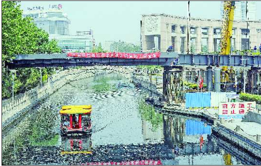
15日,恒隆广场过街天桥跨河段的主梁吊装已完毕。 本报记者 王媛 摄
