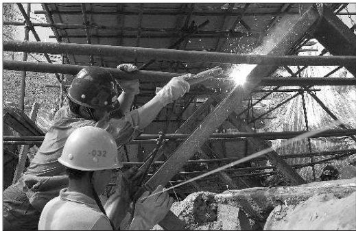
图为工作人员在对钢框架进行局部调整。 本报见习记者 邓兴宇 摄
