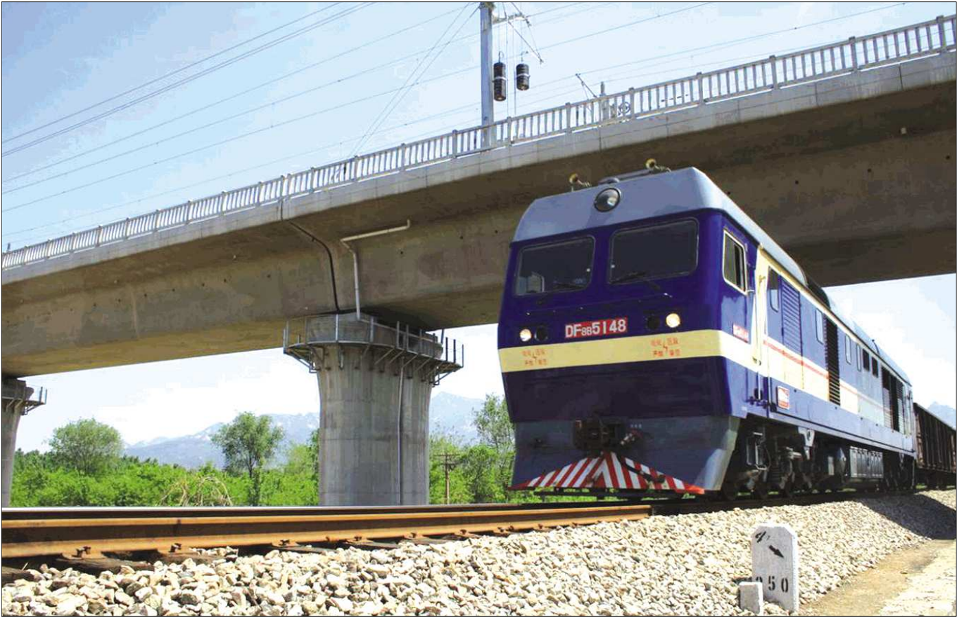
泰肥铁路上,列车穿过京沪高铁特大桥。 本报记者 孔红星 摄
