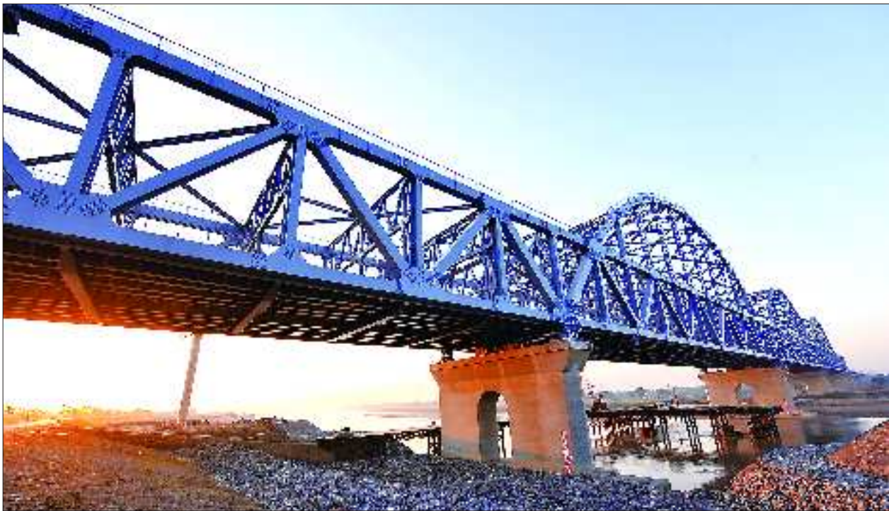
济南黄河大桥不仅是京沪高铁的重点工程、难点工程、控制性工程,还是全线最亮丽的、最具有代表性的工程。
