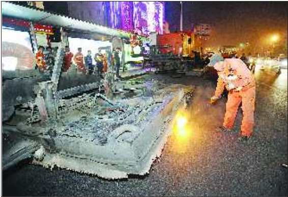
5月30日晚11点左右，在环山路与山大路之间的经十路南侧，施工人员正在对路面进行加热。
