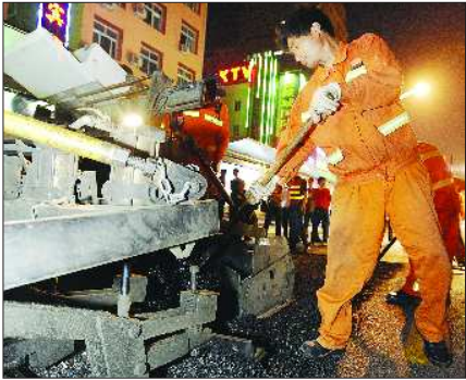
预热后，施工人员对路面进行耙松。
