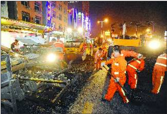
施工人员将沥青铺到加热、耙松完的路面上。
