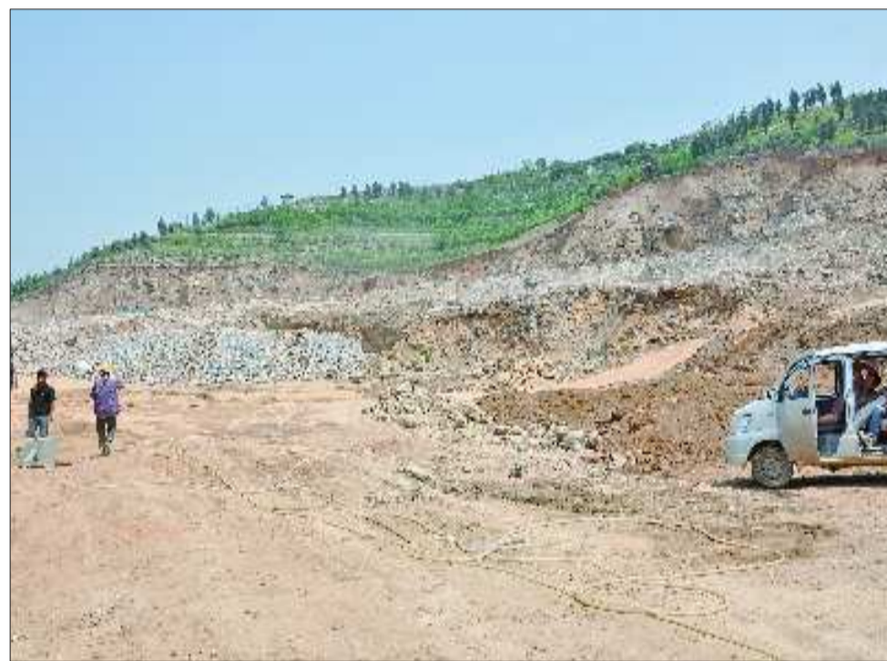
牧牛山山脚下的施工工地就在银座花园对面。本报记者 任志方 摄
