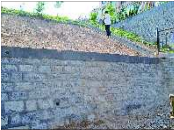
6月1日,护坡全部修复完成。本报记者 赵伟 摄
