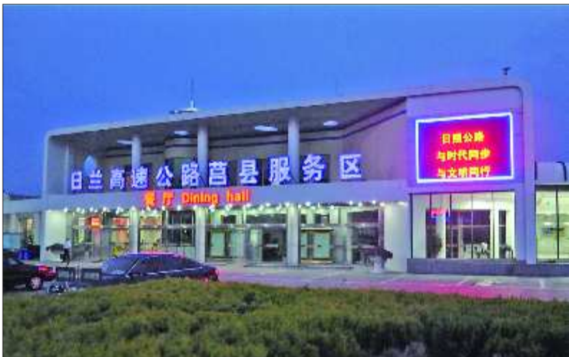
日兰高速公路莒县服务区改造后新貌。
