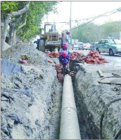
张庄路施工人员正在铺设雨水管道。 本报记者 王光照 摄
