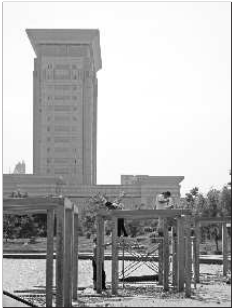
新滨公园里,工作人员正在对木桥进行修理。 本报见习记者 王传宝 摄
