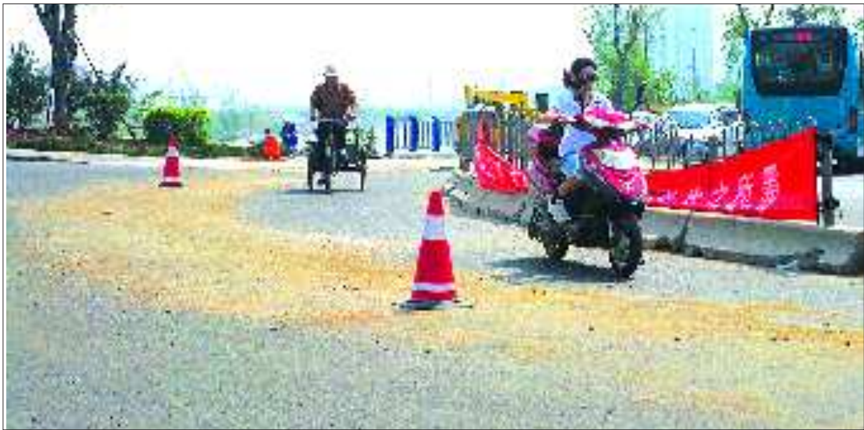
机油路面已经被撒上了沙子。
