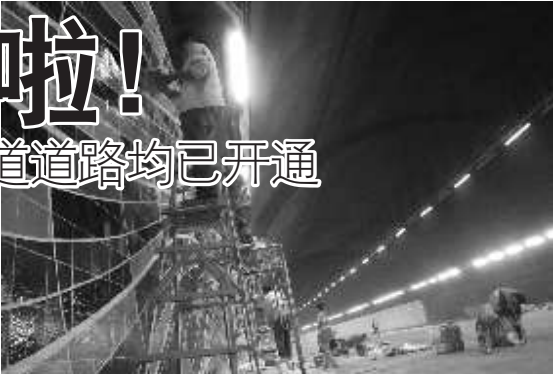
工人们正在海底隧道内安装彩幕墙。 见习记者 杨林 摄
