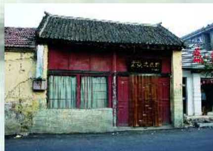
现仍保存完好的老建筑
