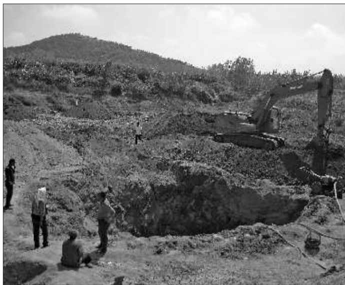
6月15日,在日照市东港区汪家官庄干涸的水库里,挖掘机正在施工挖水。 本报见习记者 彭彦伟 摄
