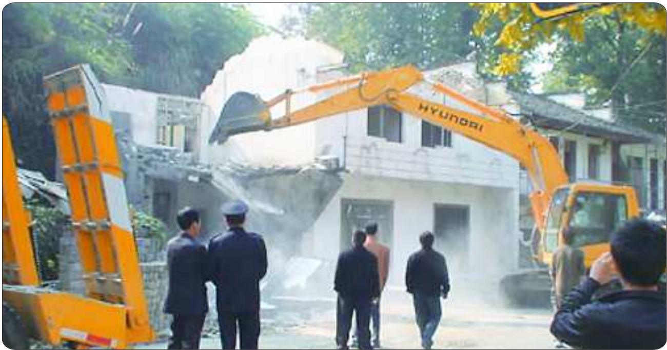
济南市一处拆迁工程现场。(资料片)
