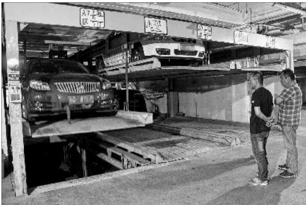
市区一住宅小区的地下立体车库。记者 徐升 摄
