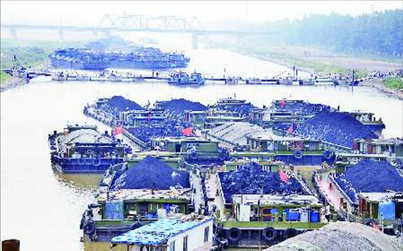
京杭大运河济宁段水位下降,八里庙运河浮桥支撑船陷入泥中,浮桥拉不开,导致大量船舶滞留。 本报记者 黄广华 摄
