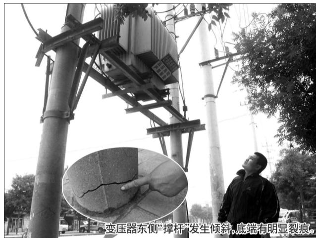
变压器东侧“撑杆”发生倾斜,底端有明显裂痕。
