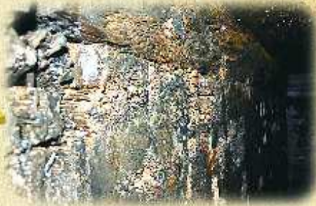
▲墓室壁上的部分木材已腐烂。
