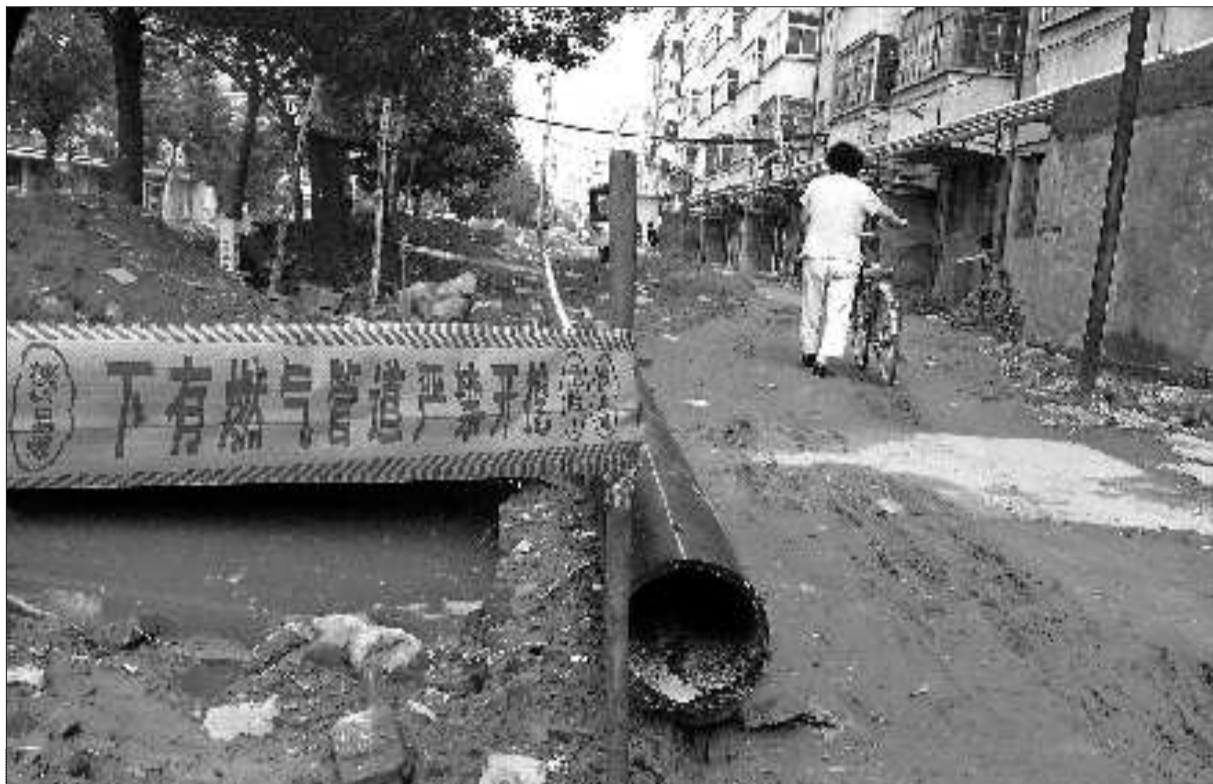
施工现场,市民小心翼翼地从小幅边走过。
