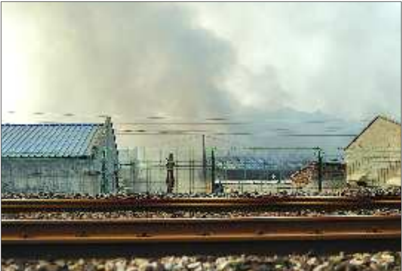
隔着铁路,可以看到挖掘机在着火区进行拆除作业。 本报记者 蔡旭超 摄
