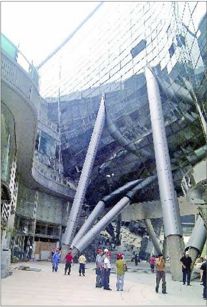
目前,恒隆广场正在加紧内部施工装修,为8月26日的正式开业做好准备。 本报记者 任志方 摄
