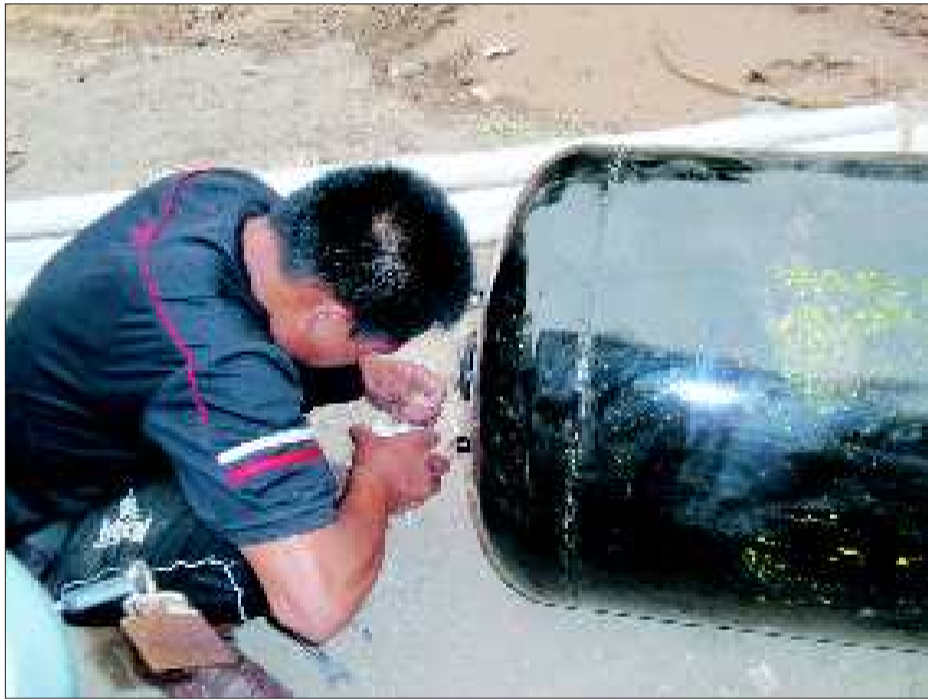
在村西北角,施工人员正给深井安装压力罐。 本报记者 潘跃全 摄
