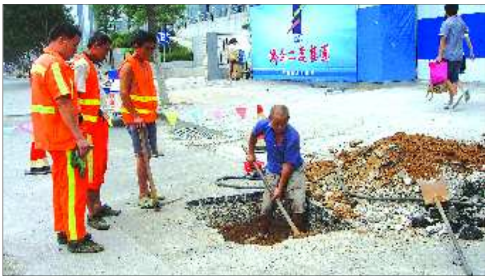
市政施工人员在冻源大街进行截污治理。 本报记者 王光营 摄
