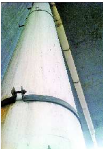
◀二环东路高架桥多数采用铁质的固定管卡。
