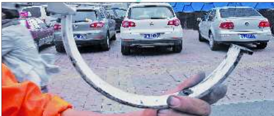
掉落的雨水管是用这种塑料材质的管卡固定的。市民袁先生提供图片
