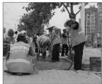
工人正在金水路沿线对人行道板进行修补。 本报记者 张晓鹏 摄
