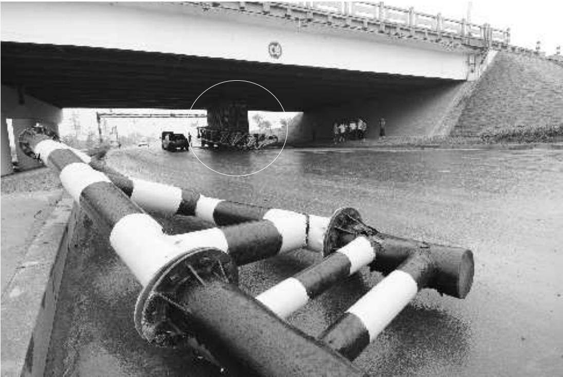
遭撞后,限高架的立柱被连根拔起,横梁挂在货车上(划圈处)。
