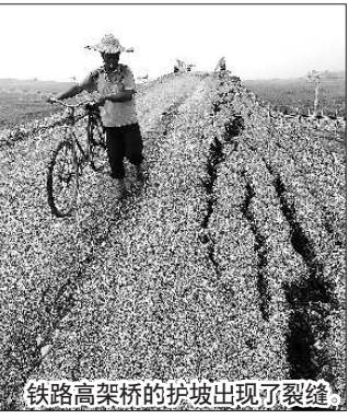
铁路涵洞积水、护坡坍塌,有的村民横穿铁路去种地,但车辆无法通过。 本报记者 郇恒吉 摄
