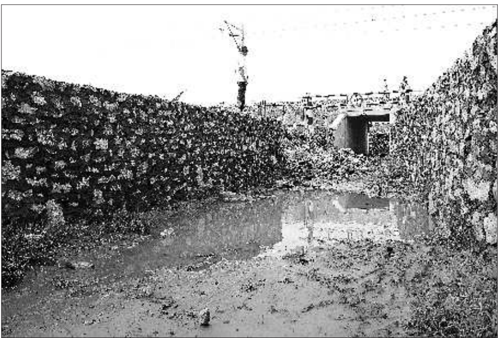
铁路涵洞积水、护坡坍塌,有的村民横穿铁路去种地,但车辆无法通过。 本报记者 郇恒吉 摄
