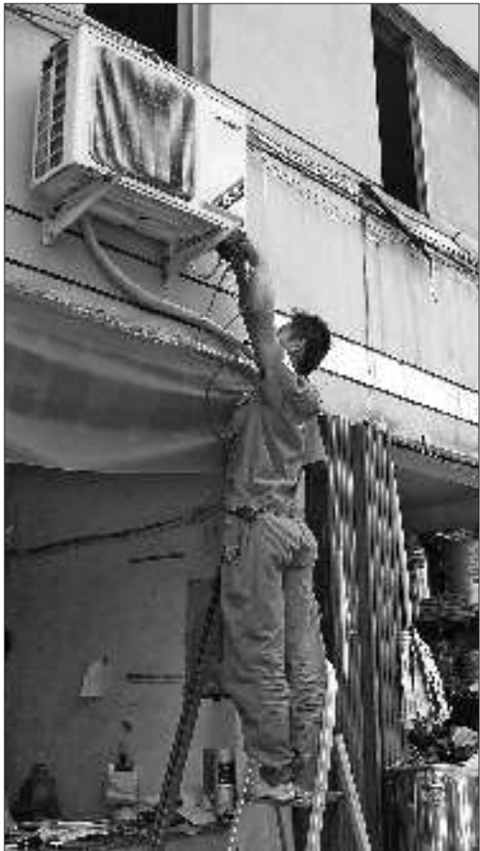
维修工王旭在测量空调系统压力。
