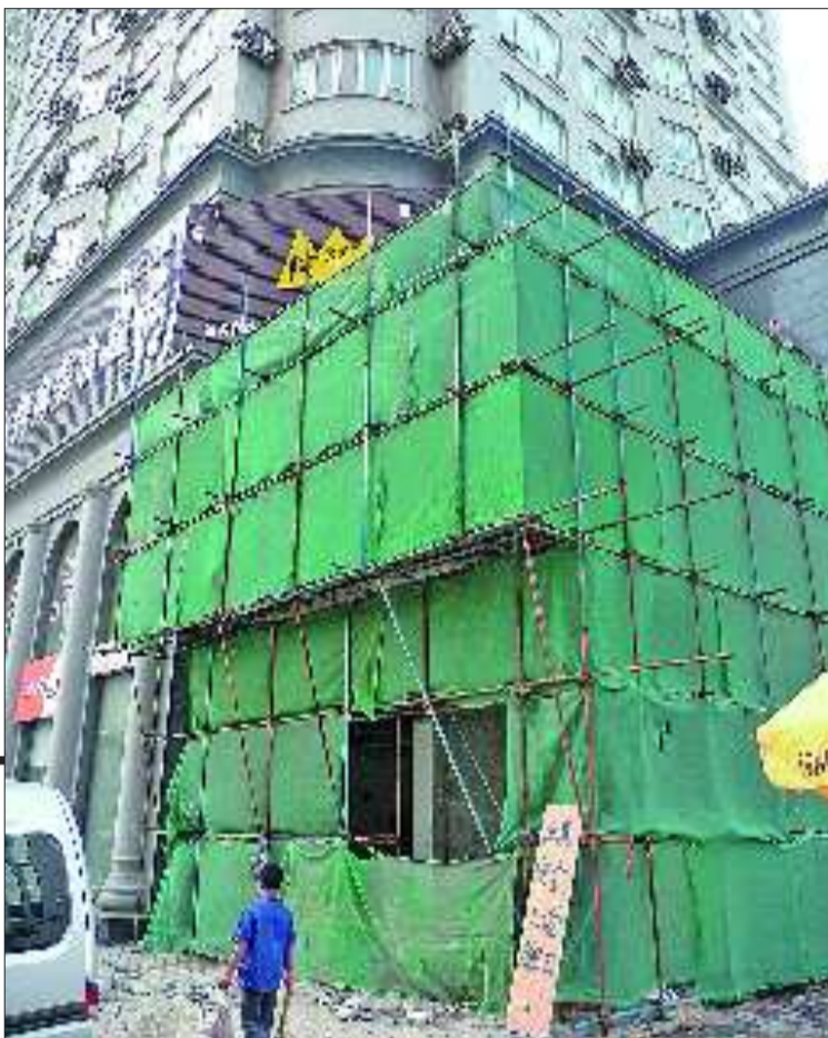
▶扩建出的钢建筑结构已经成形。
