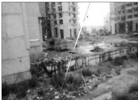
8月3日, 在北京路日照埃菲尔置业有限公司, 透过裂纹的玻璃, 可以看到停工的凯旋帝景。
