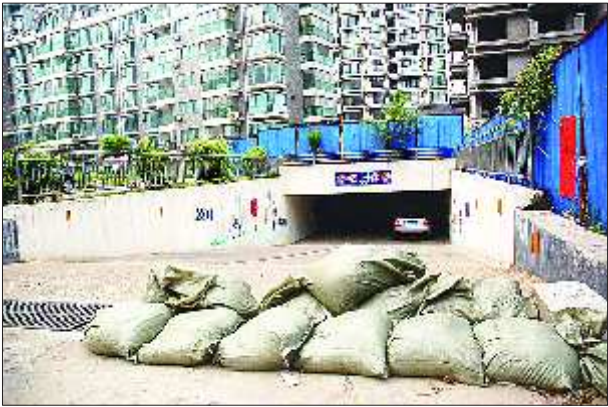
为防止地下车库被淹,风景水岸小区车库入口处排起了沙袋。 见习记者 刘涛 摄
