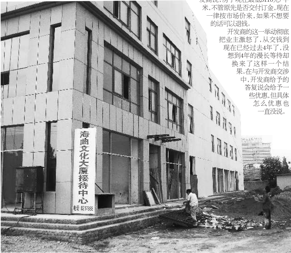
8月6日下午3点,位于海曲中路的海曲文化城,几名工人正在现场施工。 本报记者 摄
