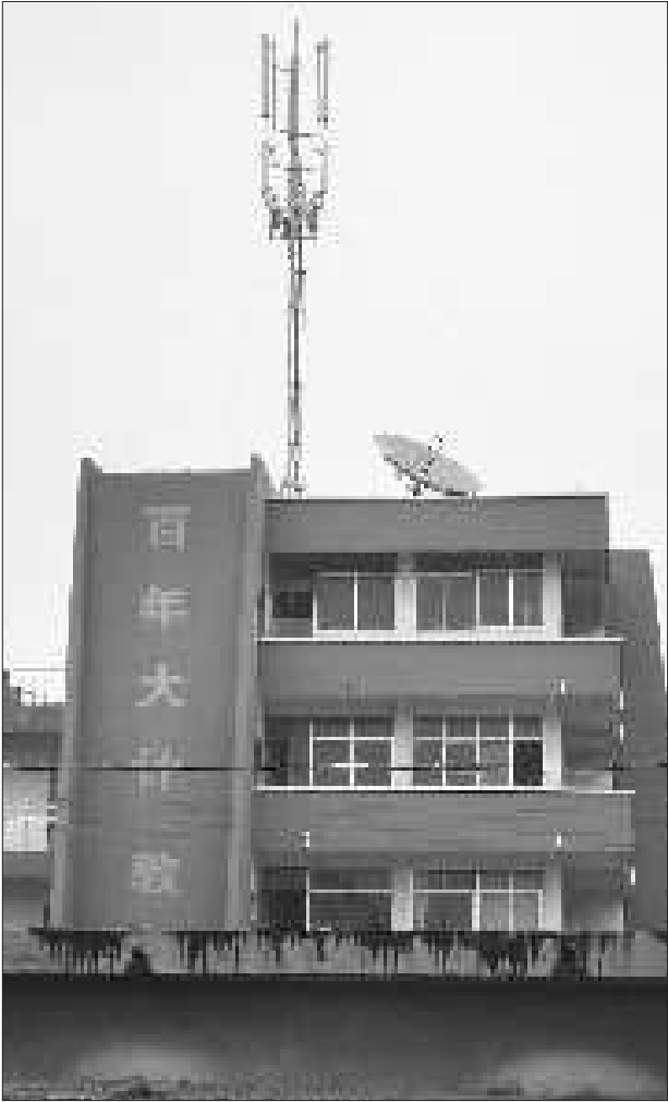
教学楼上安装的发射塔。
