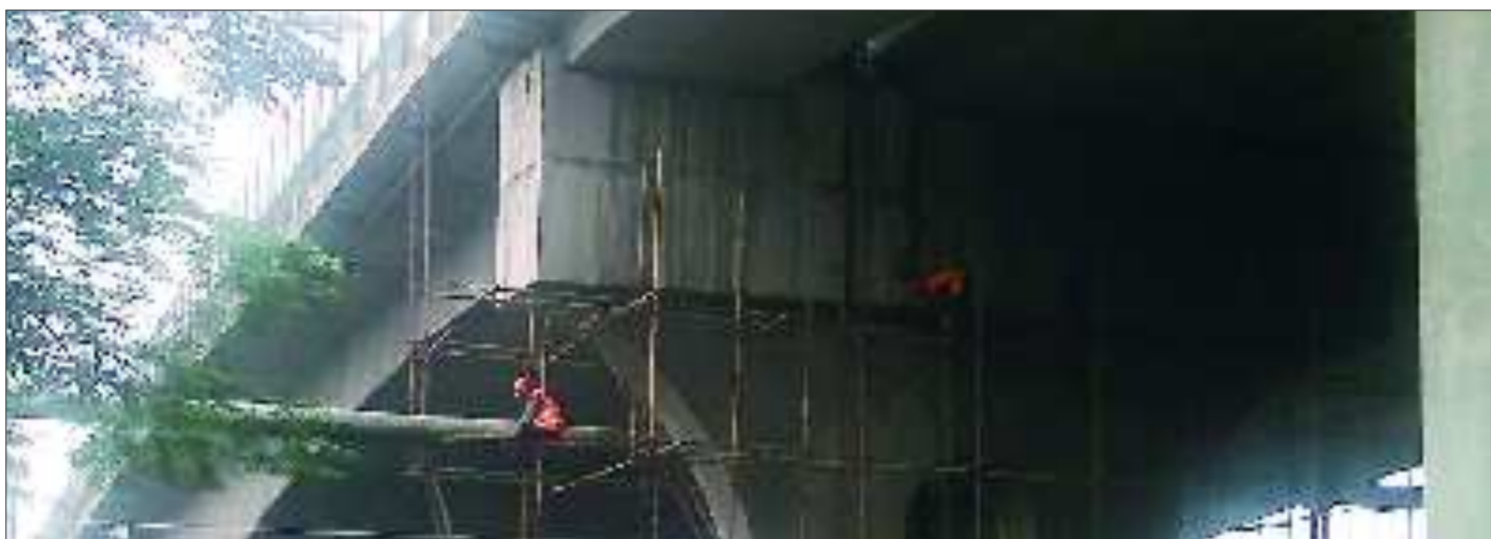
▲施工人员在经六路跨铁路桥桥墩裂缝处搭起支架,为全面整修做准备。本报记者 王光照 摄
