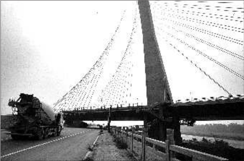
梁济运河大桥(西大桥)远景。 本报记者 张晓科 摄
