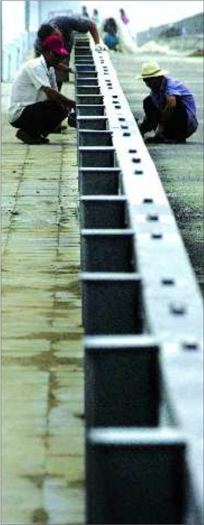
13日上午,工人在桥体护栏上粉刷金属漆,为大桥的顺利通车做最后的准备。
