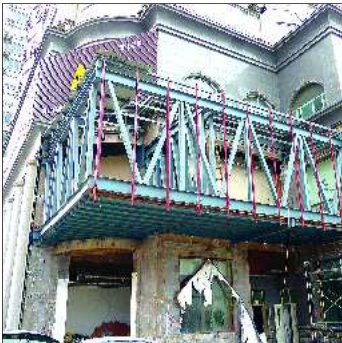
15日,“空中楼阁”已经拆得仅剩钢结构。 本报记者 李飞 摄
