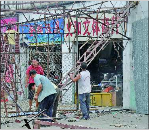
工人正在拆除违章建筑。
