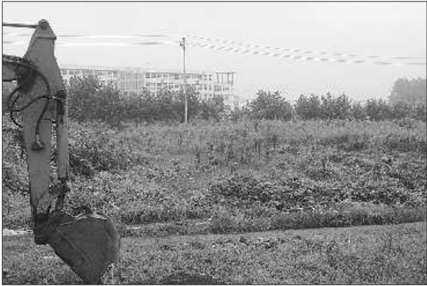
现场在进行地面清障工作,大片杂草已被清理。 记者 刘伟 摄
