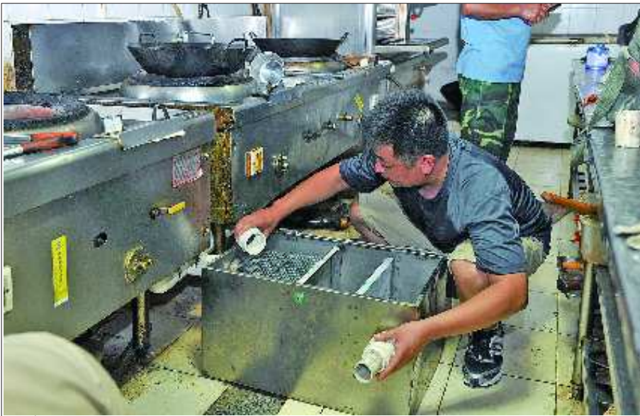
17日,历山路一家饭店厨房里,工人正安装油水分离器。本报记者 徐延春 摄
