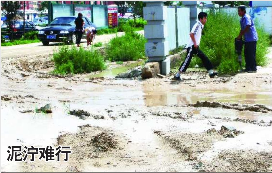
8月17日,记者在长途汽车总站前的工地上看到,连日的降雨让整个站前广场施工工地泥泞不堪,旅客进出不得不小心翼翼。据了解,站前广场改造工程预计将于“十一”前后完成。
