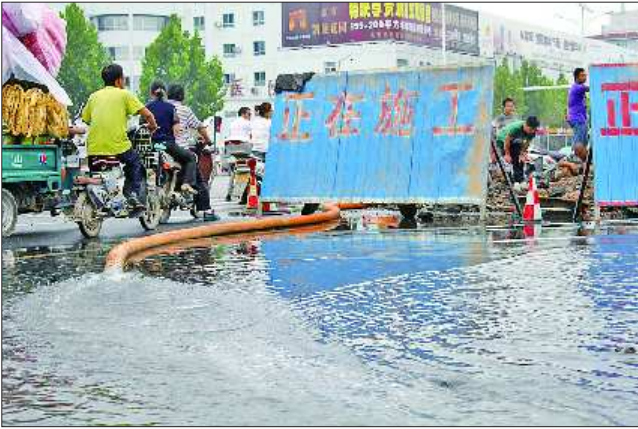
供水公司正维修破裂管道。本报见习记者 常学艺 摄
