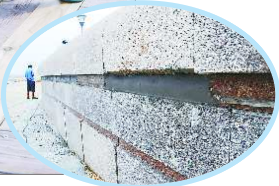
▼8月17日,岸堤防护石已用水泥加固。 本报记者 张照朋 摄
