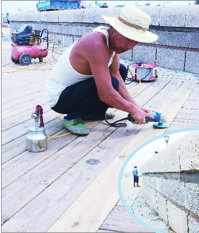
▲17日,灯塔景区受损木板栈道已铺设了新木板。
