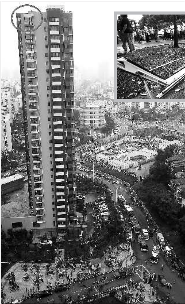
图为爆炸事故现场,文中画圈处为该楼29层爆炸位置。 本报记者 张晓鹏 杨宁 摄
