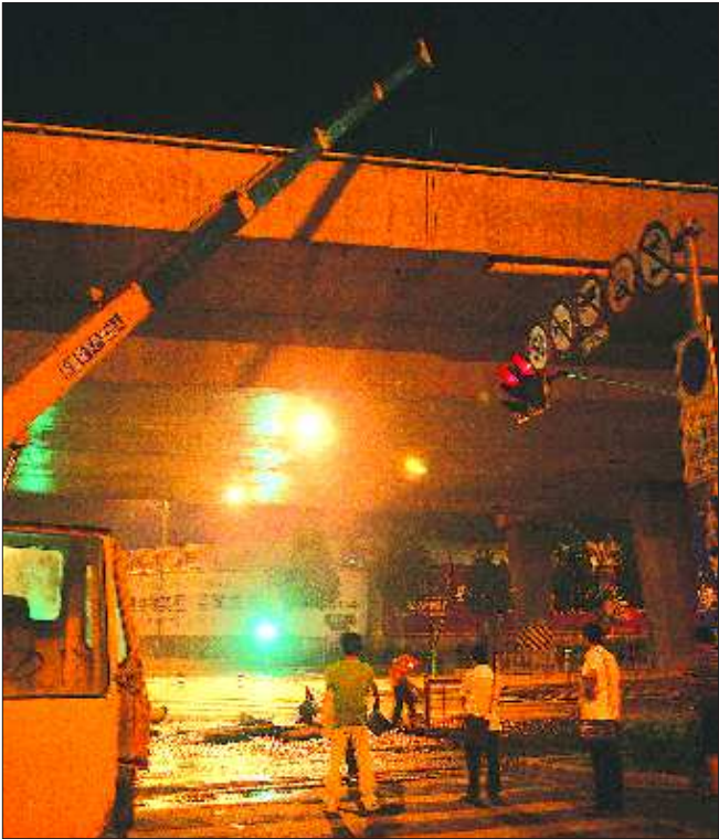
30日凌晨,施工人员调来吊车,开始拆除二环东路高架桥上的横向雨水管。
